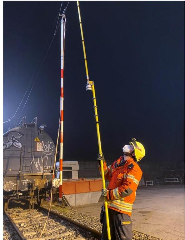
erhielten wir eine zweite Erdungsgarnitur von der deutschen Bahn. Acht Kameraden sind seitdem ausgebildet und berechtigt bei Einsätzen im Gleisbereich die Oberleitung zu Erden. Die Erdung ist wichtig um gefährliche „Restspannung“ (bis zu 8000 V) abzuleiten. Sollte der sehr unwahrscheinliche Fall eintreten und eine abgeschaltete Oberleitung versehentlich wieder eingeschaltet werden, schützt uns die eingebrachte Erdung.
